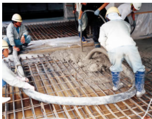
5, 底版部コンクリート打設
