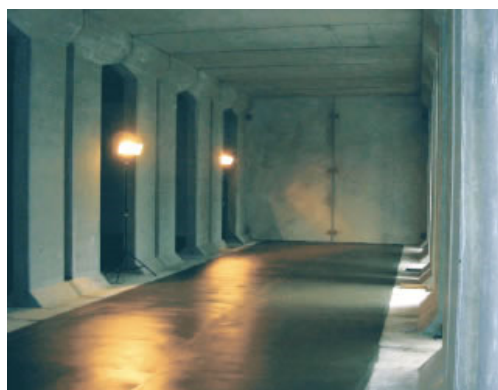
6, コンクリート打設完了
