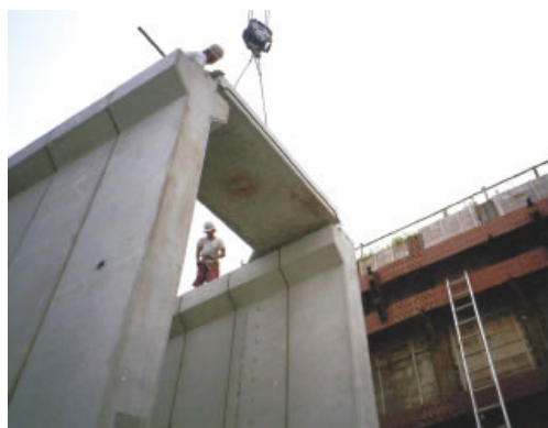
2, スラブの据付
