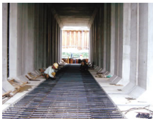
4, 底版現場打ち部の配筋
