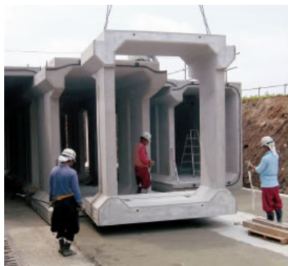
1, ブロックの据付（ボックス型タイプ）
