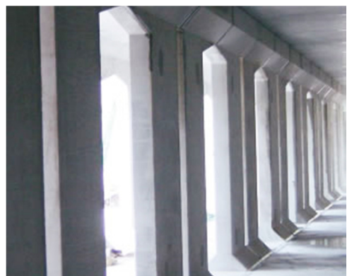
7, 完成した遊水地の内部
