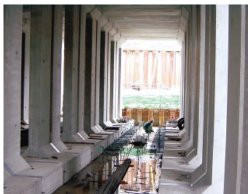
3, プレキャストブロックの据付完了
