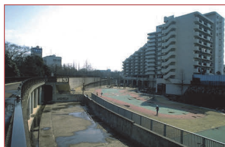
マンションの共有スペースを活用した遊水地
