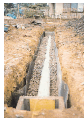
個人住宅 雨水浸透枳配置例
