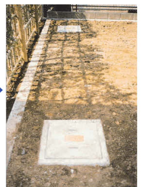
浸透トレンチの施工状況例
