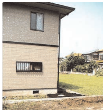
浸透枳の施工状況例
