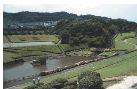
公園と一体となった調整池
