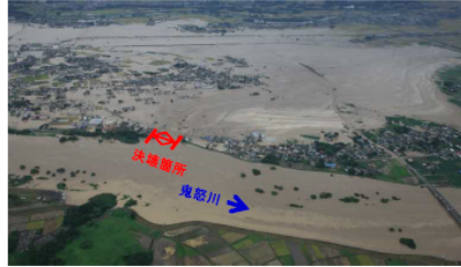
被災状況(全景写真)
