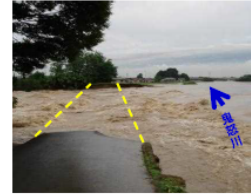
被災状況(拡大写真)
