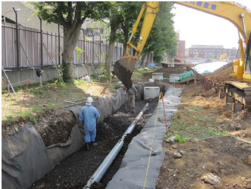
雨水貯留・浸透用とケヤキの生育基盤としてJ・ミックスを施工 2014年8月
