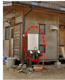
雨水タンクの設置
