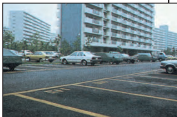
透水性舗装を施した駐車場
