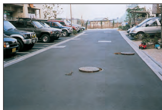
全景 (No.1 地下貯留池)
