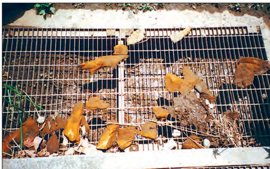
閉塞したオリフィスの例（貯留施設）
