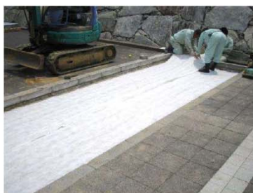
透水シート設置
