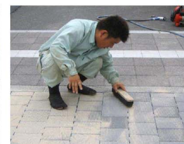
仕上げの掃き込み
