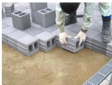
ブロックの敷設
