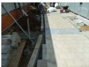
端部ブロックの幅が小さい場合
