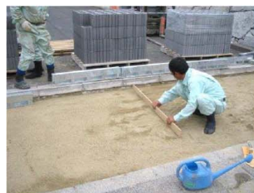
サンドクッションの転圧・敷均し
