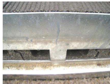
高圧洗浄等で土砂などを取り除く
