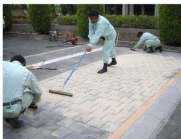
目地砂の掃き入れ・転圧
