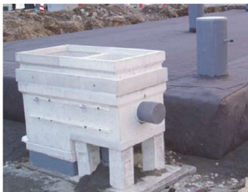
コンクリート製除塵管理枳の施工例
