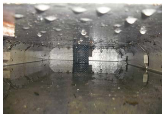
写真2 施工後の貯留槽内部
