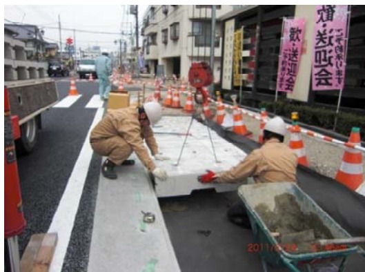
写真1 施工状況写真（据え付け）
