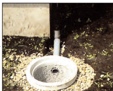
浸透ますの施工状況
