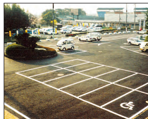
完成した透水性舗装
