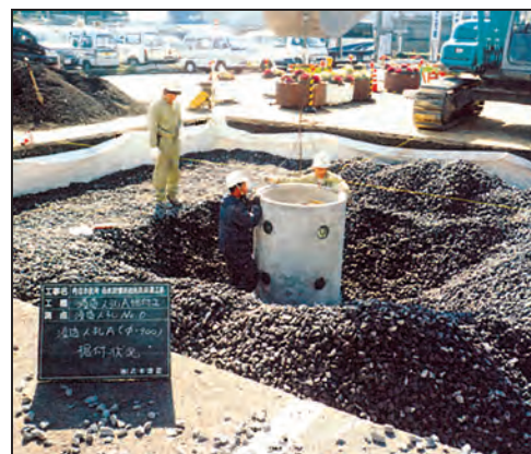
大型浸透ますの施工状況
