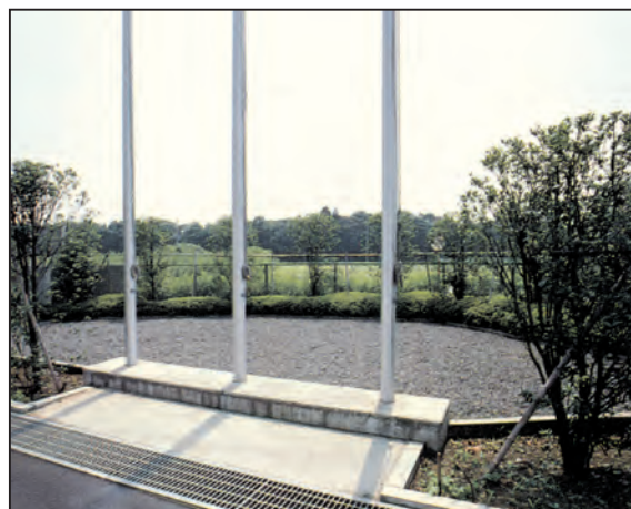
浸透池の全景
