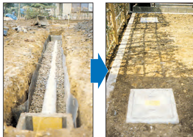
浸透トレンチの施工状況
