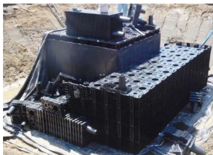
貯留槽部 組立経過
