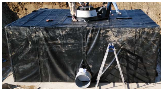
施設外観 (埋め戻し前)
