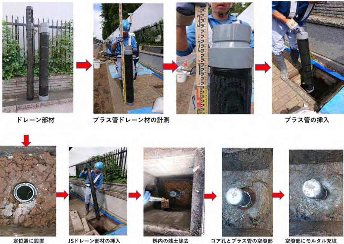
写真3 JS ドレーンプラス管の施工要領
