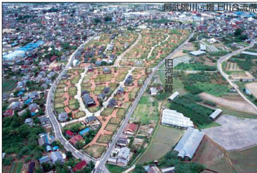
上空から見た諏訪野団地
