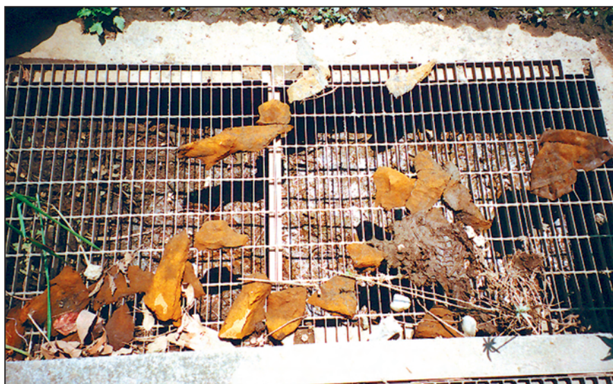
閉塞したオリフィスの例（貯留施設）
