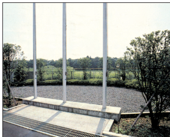
浸透池の全景
