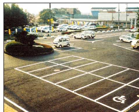
完成した透水性舗装
