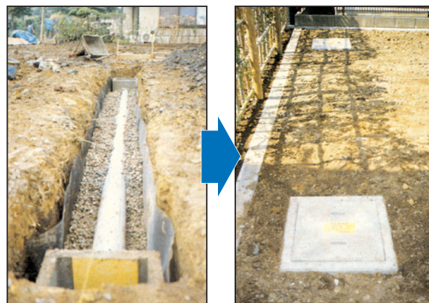
浸透トレンチの施工状況
