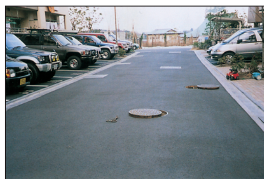
全景 (No.1 地下貯留池)
