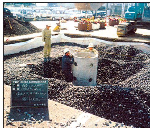
大型浸透ますの施工状況
