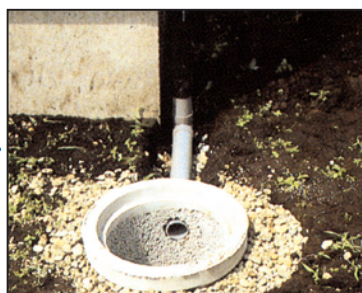
浸透ますの施工状況
