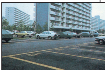
透水性舗装を施した駐車場
